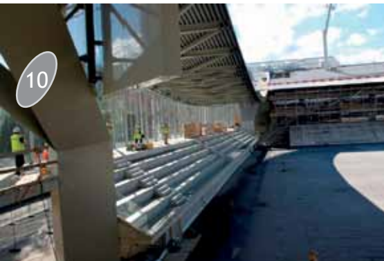
Eteläkatsomon ripustettu kaareva katto lasiseiniin.
