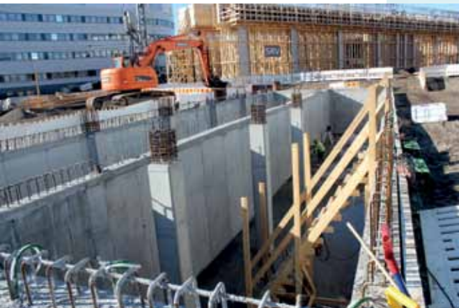
Palosammutusjärjestelmän vesisäiliöitä ja muottien tukirakenteita.
