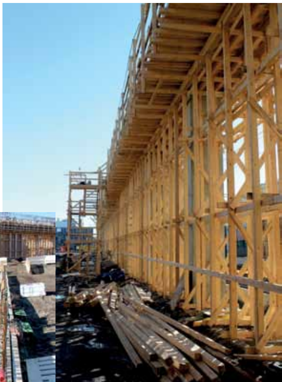
Palosammutusjärjestelmän vesisäiliöitä ja muottien tukirakenteita.
